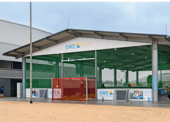
Im April wurde die SWE Arena im Sportpark Weil eröffnet. Auf dem Dach produziert eine PV-Anlage Strom.
